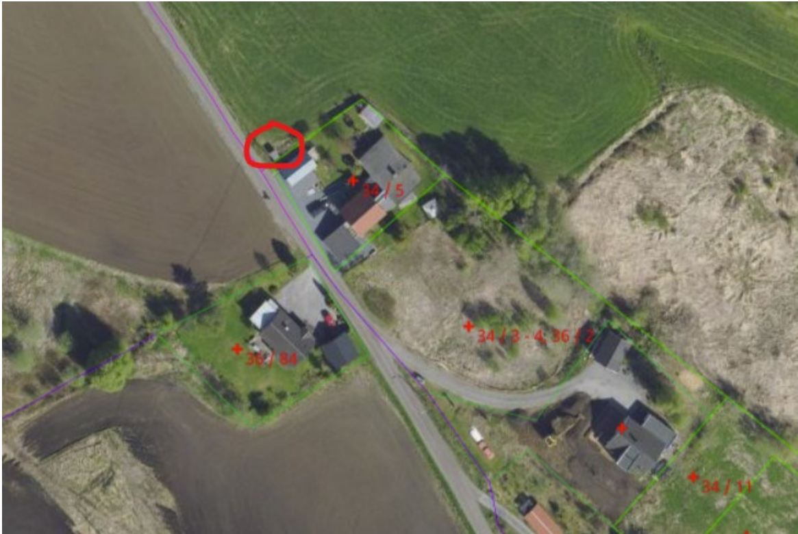
Figur 10 Eksisterende trafostasjon (Kilde: Norgeskart.no).
